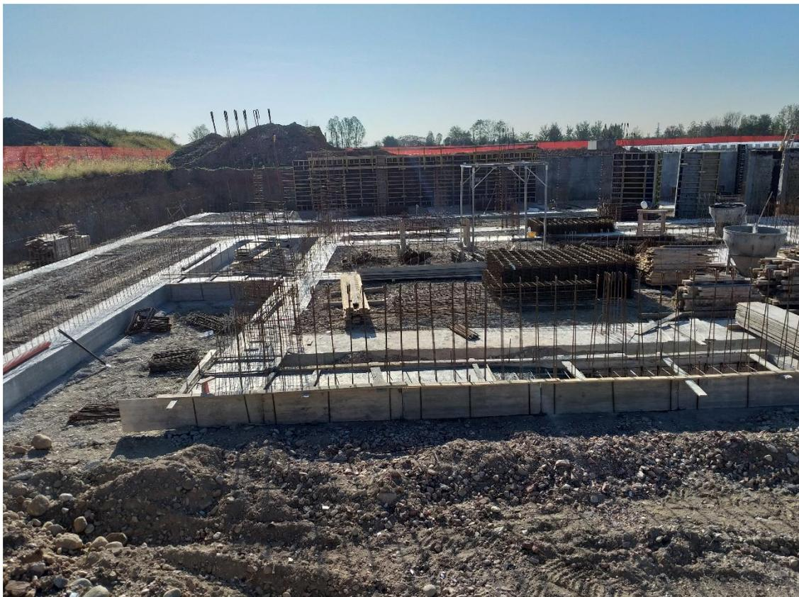
*Strutture di fondazione ed elevazione del piano interrato*
